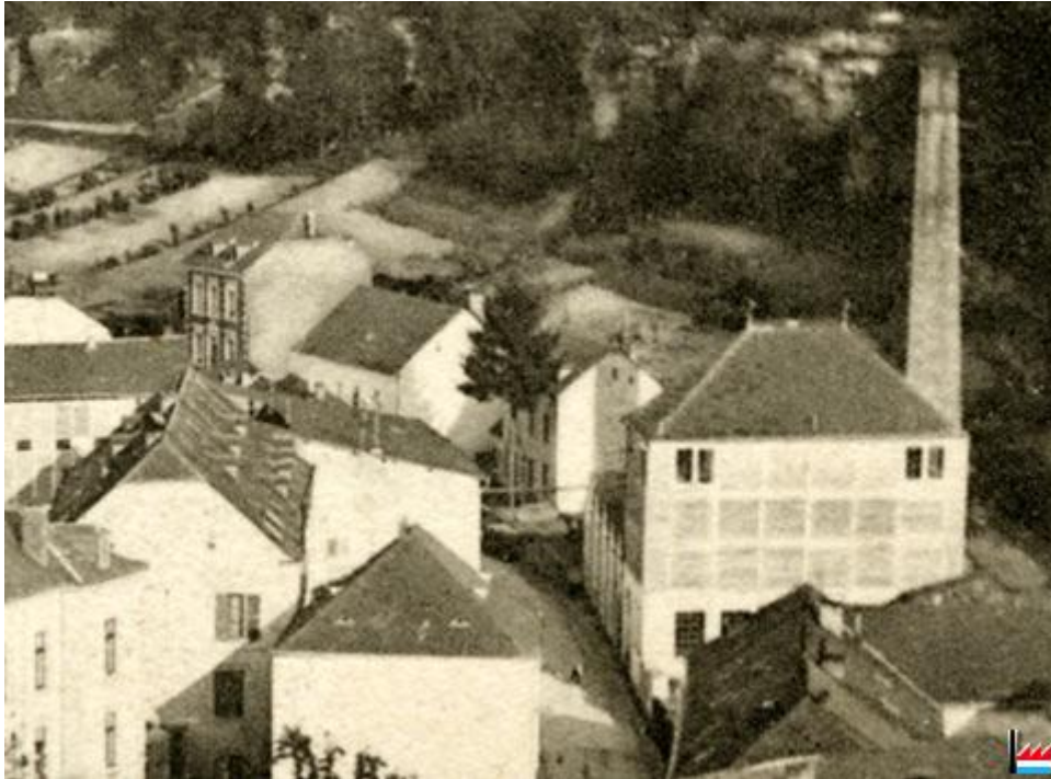
Teinturerie Bonne-Sichel à Larochette: le bâtiment à droite avec la cheminée), ainsi que le bâtiment avec toiture en dent de scie (shed), vers 1905 (Collection: jmo )
