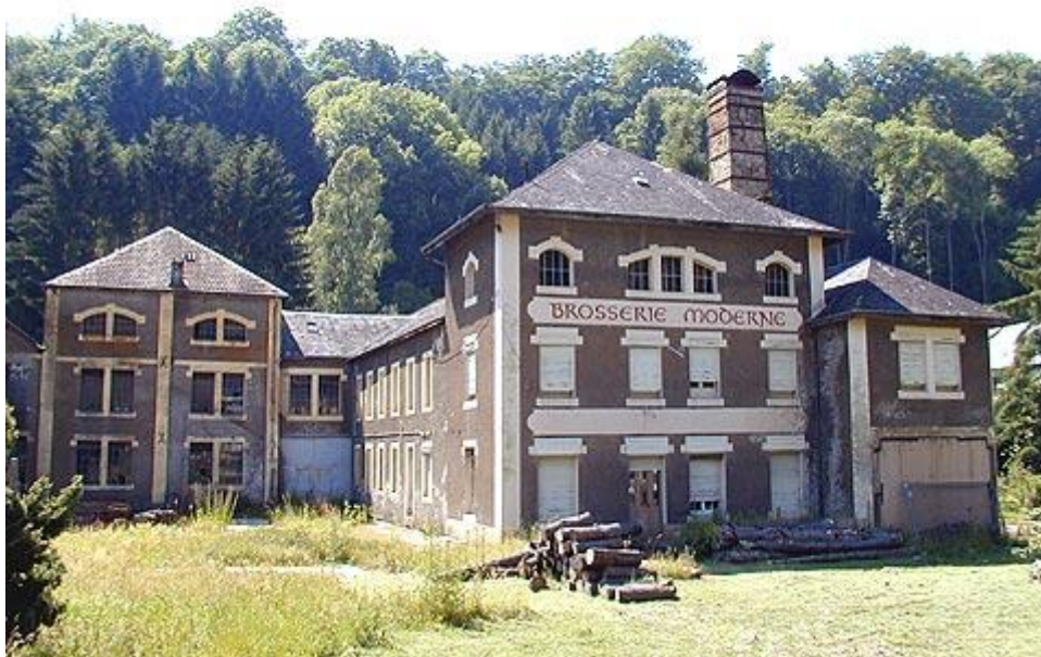
Ancienne usine "Brosserie Moderne" à Larochette (Photo: 26.6.2001 jmo )
