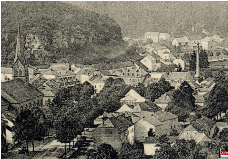
Fabrique de chaussures Lutgen (le bâtiment à droite avec la cheminée) à Larochette
