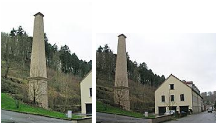
Cheminée en pierres taillées restaurée (Photos: 7.12.2007 jmo )
